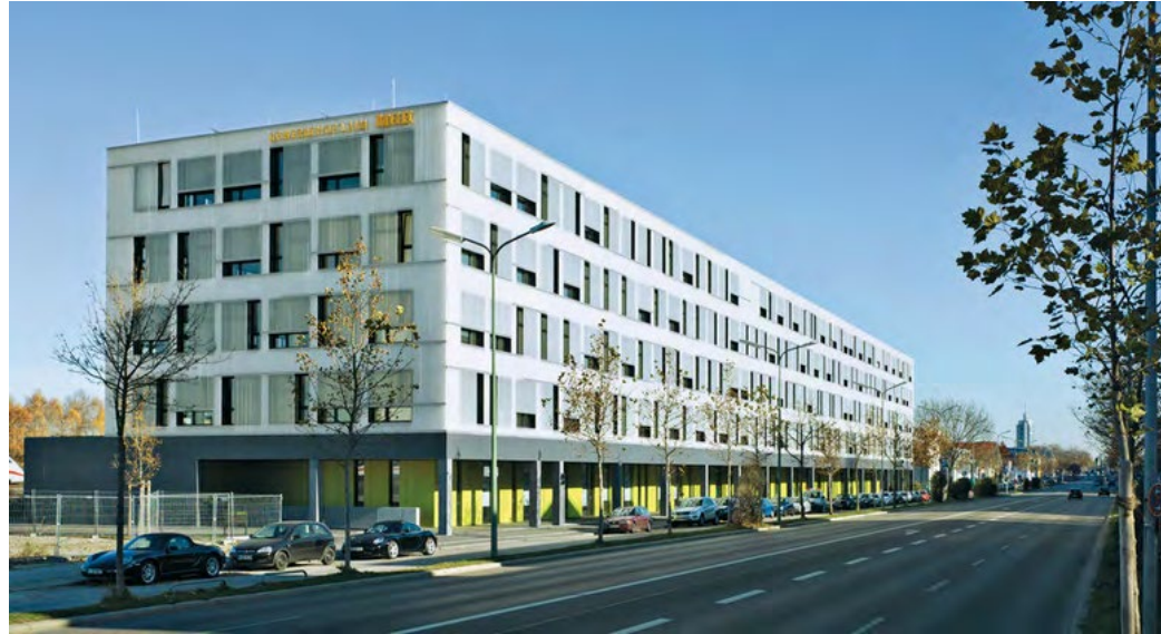
Stacked industrial - Concrete frame Gewerberhof Laim, Munich, Bogevischs Buero
